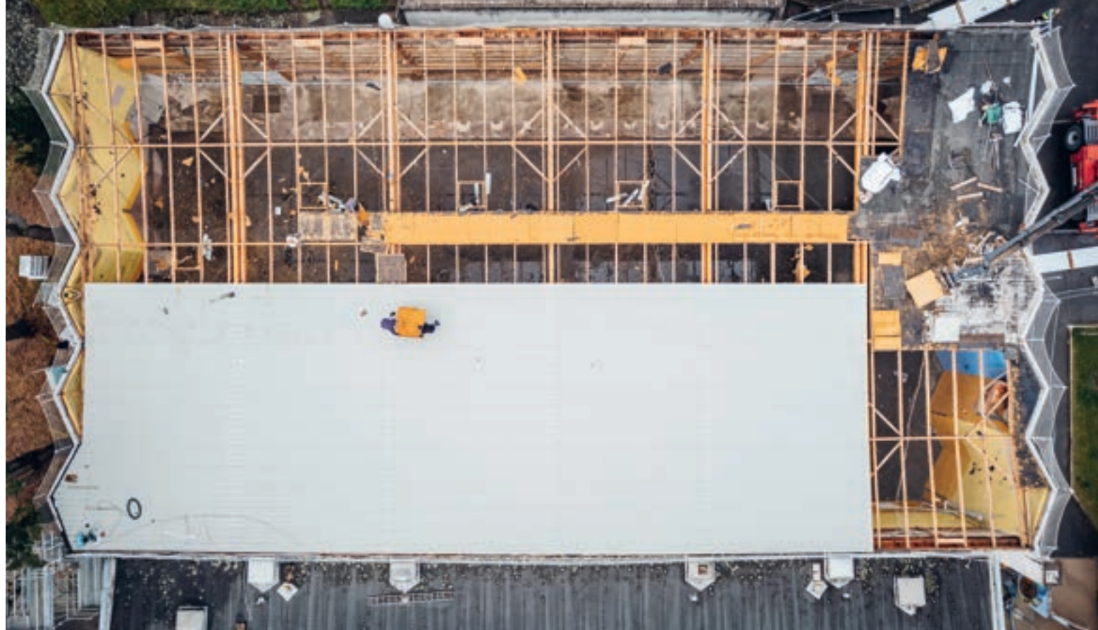
Réfection de la toiture du gymnase Joël Dubois.
