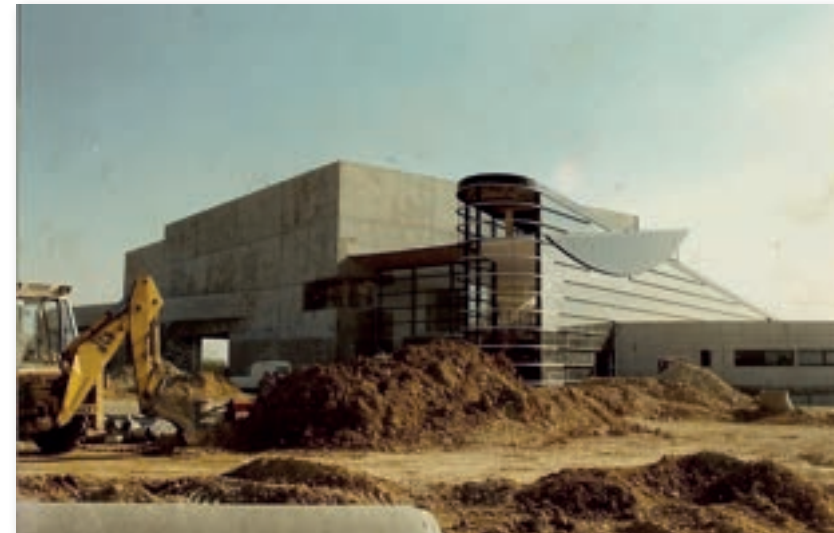
▲ Travaux de construction du Piano'cktail, 1989
