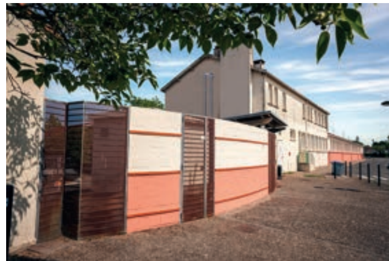
Les travaux dans les écoles. Ici, l'école maternelle Françoise Dolto.
